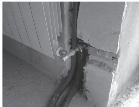
Рисунок 11.12 – Варианты бокового подключения радиатора из штробы стены
