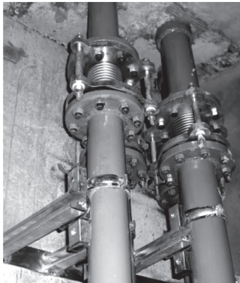
Рисунок 11.3 – Пример установки сильфонных компенсаторов на стояках системы отопления
