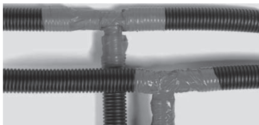
Рисунок 11.1 – Защита соединений трубопроводов перед заделкой
