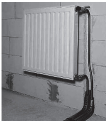
Рисунок 11.12 – Варианты бокового подключения радиатора из штробы стены
