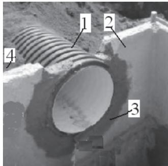
1 – труба; 2 – стенка; 3 – цементная заделка; 4 – грунт
