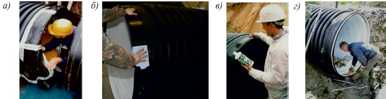
*а)* снятие защитной пленки; *б)* удаление загрязнений с внешней поверхности спигота бумажной салфеткой; *в)* обезжиривание внешней поверхности спигота тампоном, смоченным в растворителе; *г)* очистка внутренней поверхности раструба и закладного элемента волосяной щеткой
